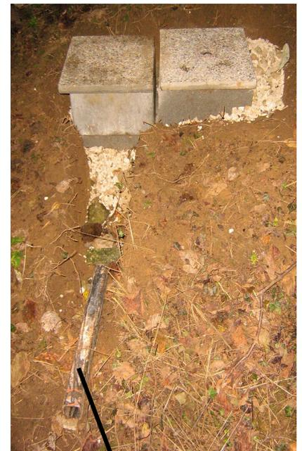
*Tube de sortie de section carrée de 5 cm*
